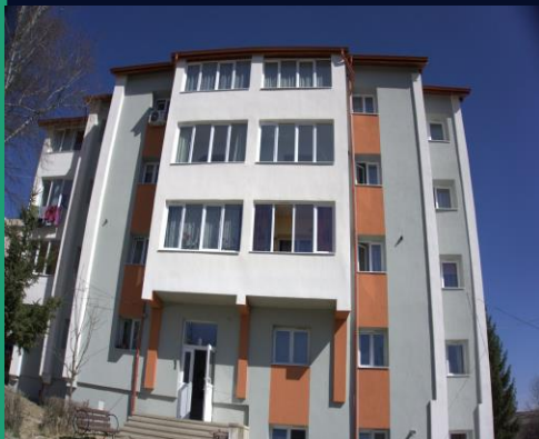
Bloc locuințe reabilitat
