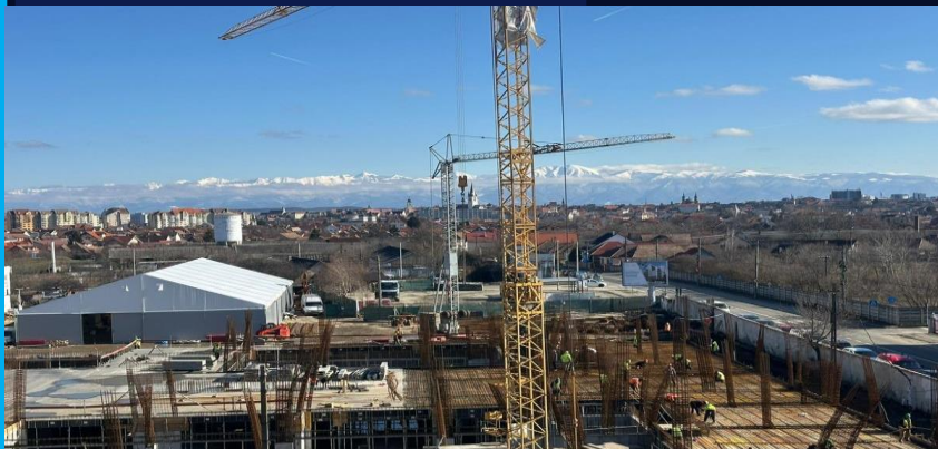
Șantier The Lake Home · vedere panoramică
