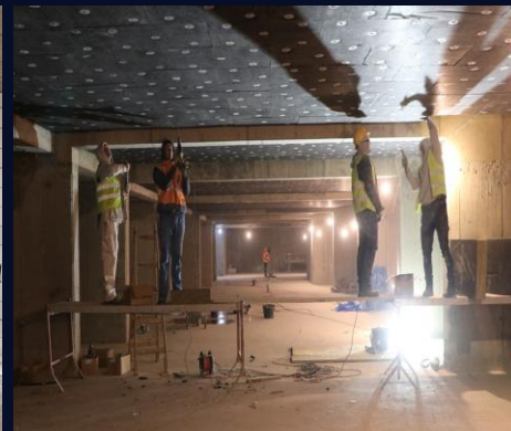
Echipa DMX · izolare acustică plafon
