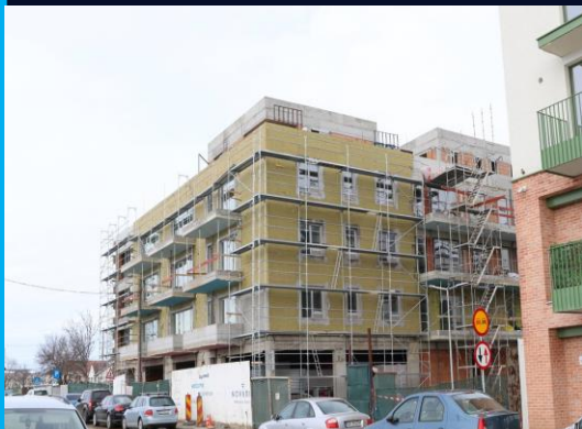
Fațadă lucrări de termoizolare
